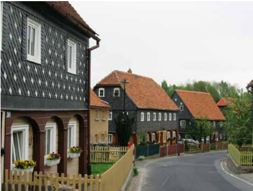
Abb. 8: Obercunnersdorf, Ortsbild mit Umgebndehäusern.
